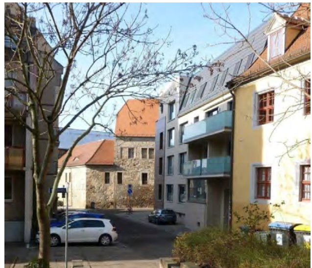
↑ Große Klausstraße, vorne rechts: Denkmalgeschützter Ackerbürgerhof mit Bestandteilen aus dem 15.–18. Jahrhundert, direkt daneben: Sanierteres Gebäude in Plattenbauweise und im Hintergrund die Neue Residenz (4)
