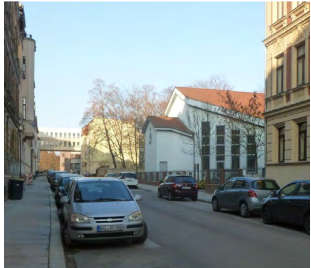
↑ Neuapostolische Kirche in der Pfälzer Straße: Das Gebäude bricht mit der geschlossenen Blockrandbebauung, das Grundstück verfügt über eine qualitätsvolle Einfriedung und Stadtbäume. (4)
