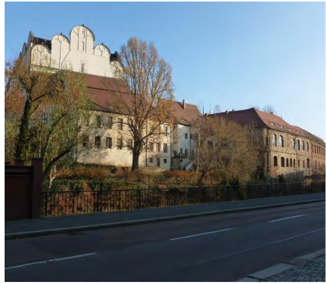
↑ Westansicht des Domes und der Neuen Residenz: Stadtgestalt- und ortsbildprägende historische Raumkante entlang des Mühlgrabens (4)
