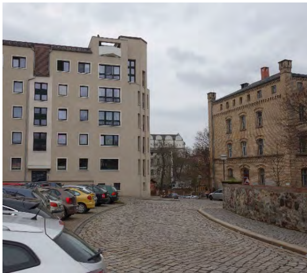
↑ Gebäude in Plattenbauweise im sanierten Zustand in der Kleinen Schlossgasse (4)
