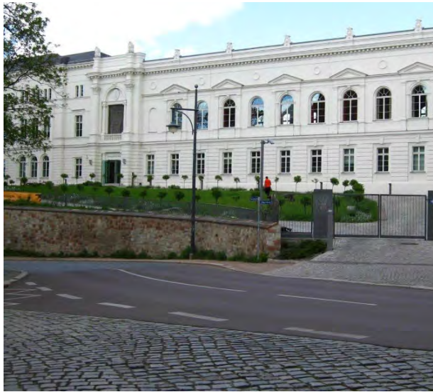
↑ Leopoldina: Ehemaliges Logenhaus als ortsbildprägende Raumkante am Altstadttring mit direkter Sichtbeziehung zur Moritzburg und dem ehemaligen Physikalischen Institut (4)
