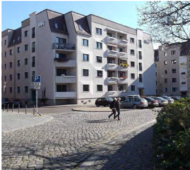
↑ Sanierter Plattenbau am Schlossberg mit Sichtbeziehung zur Moritzburg: Hervorzuheben ist die Fassadengestaltung, plastisch hervortretende Fassadenelemente greifen das ursprüngliche Fugenraster auf. (4)
