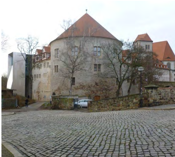
↑ Moritzburg, Blick auf den südöstlichen Turm: Links im Bild die Neubaugergänzung des Kunstmuseums, im Vordergrund historisches Pflaster und Bruchsteinmauer (4)
