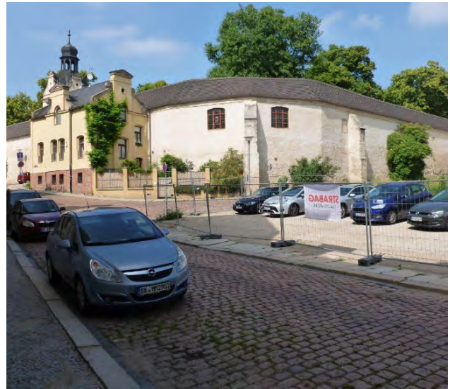
↑ Südwestliche Ecke des Stadtgottesacker: Gut erkennbar die umlaufende fünf- bis sechsmeter hohe Mauer mit Satteldach und der Baumbestand im innern der Anlage (4)
