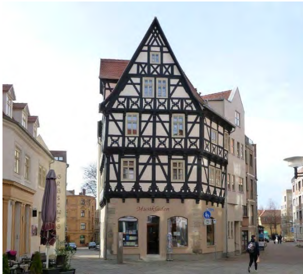
↑ Graseweghaus als Sichtfachwerkbau mit hervorkragenden Stockwerken in repräsentativer Ecklage (4)
