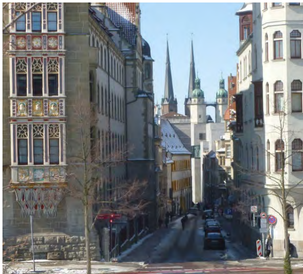
↑ Eingangssituation in die Altstadt vom Hansering durch die Rathausstraße mit Sichtbeziehung zur Marktkirche.:Prägende Ecksituation mit Fernwirkung, links: Landgericht mit prächtigem Erker, rechts: Wohn- und geschäftshaus mit Eckerker (4)
