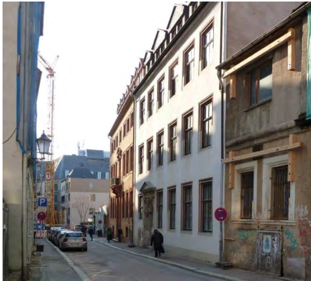
↑ Repräsentative Wohnhäuser in der Brüderstraße: Ortsbildprägend sind die Geschosshöhe, die profilierten und stuckierten Fensterfaschen sowie die anspruchsvolle Gestaltung der Fassaden. (4)
