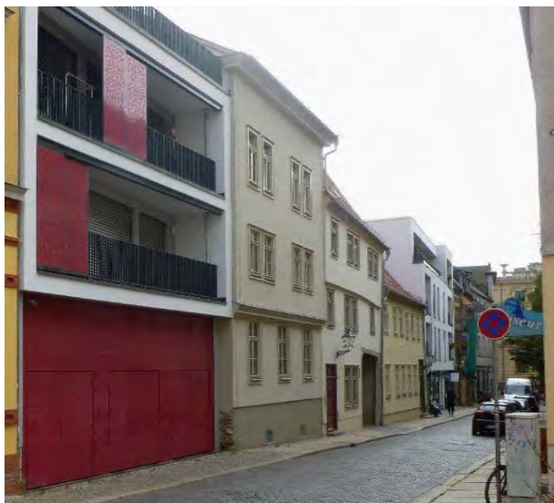
↑ Lückenschluss durch Neubauten in der Mittelstraße: Die Neubauten greifen die vorspringenden Obergeschosse sowie die Gebäudehöhen des nebenstehenden Gebäudes auf. (4)
