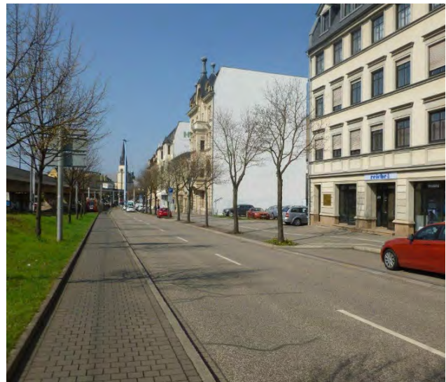
↑ Waisenhausring in Richtung Franckeplatz: Die Stadtgestalt ist verletzt und es fehlt ein Lückenschluss. Die nicht abgegrenzte Baulücke beeinträchtigt die Stadtgestalt. (4)
