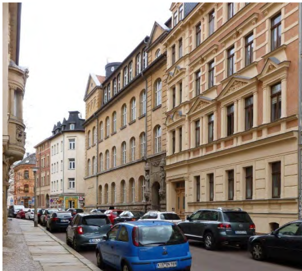
↑ Markante gründerzeitliche Wohngebäude am Weidenplan mit reich verzierten Fassaden, Portalen und hohen Fenstern bei einem breitem Straßenquerschnitt (4)
