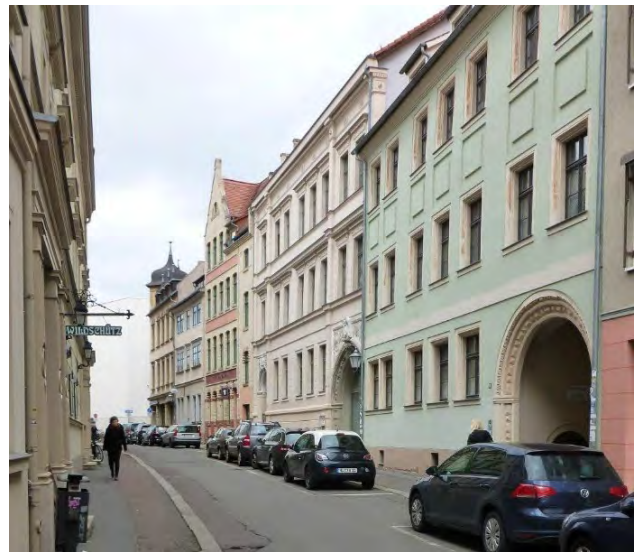
↑ Wohnhäuser in der Barfüßerstraße mit Satteldach, repräsentativen Tordurchfahrten und Rundbogenportalen sowie Fenstergewänden (4)
