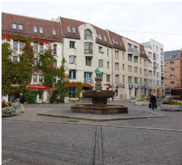
↑ Alter Markt mit Eselsbrunnen, Wohn- und Geschäftshäuser der Nordseite in postmoderner Formensprache und mit Ladengeschäften im Erdgeschoss, Natursteinbeläge auf der Straße und der Platzfläche (4)
