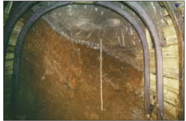
Untertägiger Aufschluss der Halle-Störung von 1982 auf dem Marktplatz 60 m östlich der Commerzbank. Rotliegendes wird von Zechstein überlagert.
