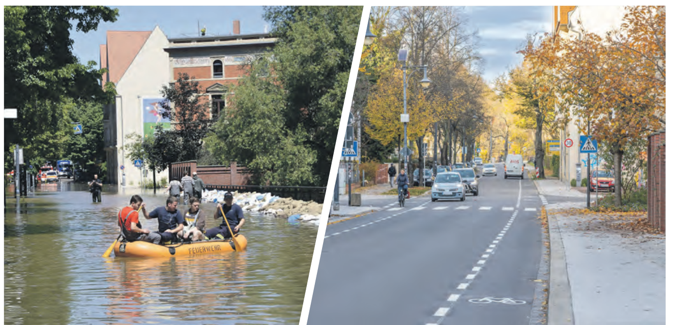
In der Klostervorstadt hat die Stadt neben dem Robert-Franz-Ring (Foto, 2020 bis 2021) auch die Franz-Schubert-Straße, die Ankerstraße, die Pflzer Straße und Tuchröhmen saniert. Im Robert-Franz-Ring wurden nach dem grundhaften Ausbau auch Schutzstreifen für Radfahrende angelegt.
