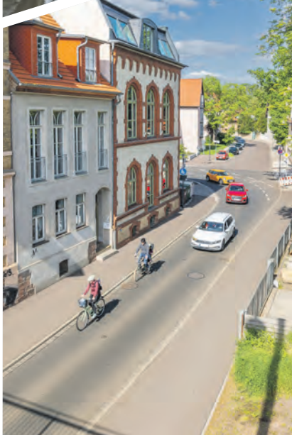
Der 500 Meter lange nördliche Abschnitt der Talstraße vom Anschluss Kröllwitzer Straße bis zur Unteren Papiermühlenstraße wurde 2018/2019 grundhaft saniert.
