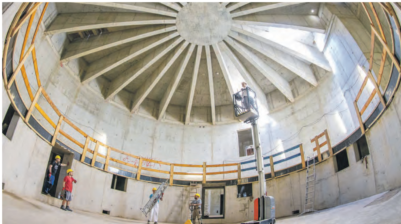
Die Arbeiten am Planetarium schreiten voran. Mitte kommenden Jahres soll die Eröffnung gefeiert werden.
