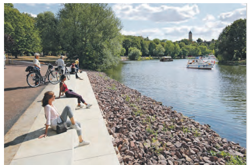
Auch die Ufertreppe am Fuße der Klausberge konnte mit Hilfe der Fluthilfe des Landes instand gesetzt werden. Foto: Thomas Ziegler
