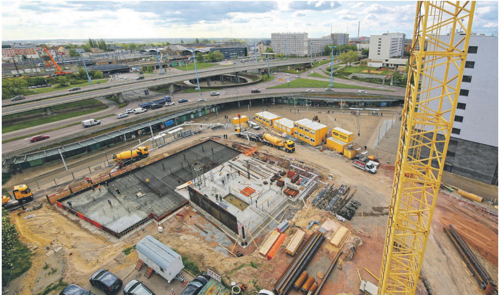
Der Riebeckplatz entwickelt sich weiter: Die Hallesche Wohnungsgesellschaft mbH (HWG) saniert vor Ort neun Häuser mit 400 Wohnungen und baut ein zehngeschossiges Wohn- und Geschäftshaus am Eingang zur oberen Leipziger Straße. Ergänzt wird das Gebäude durch einen Supermarkt. In unmittelbarer Nachbarschaft errichtet die GP Hochbau GmbH ein Hotel mit 186 Zimmern (Foto). Foto: Thomas Ziegler
