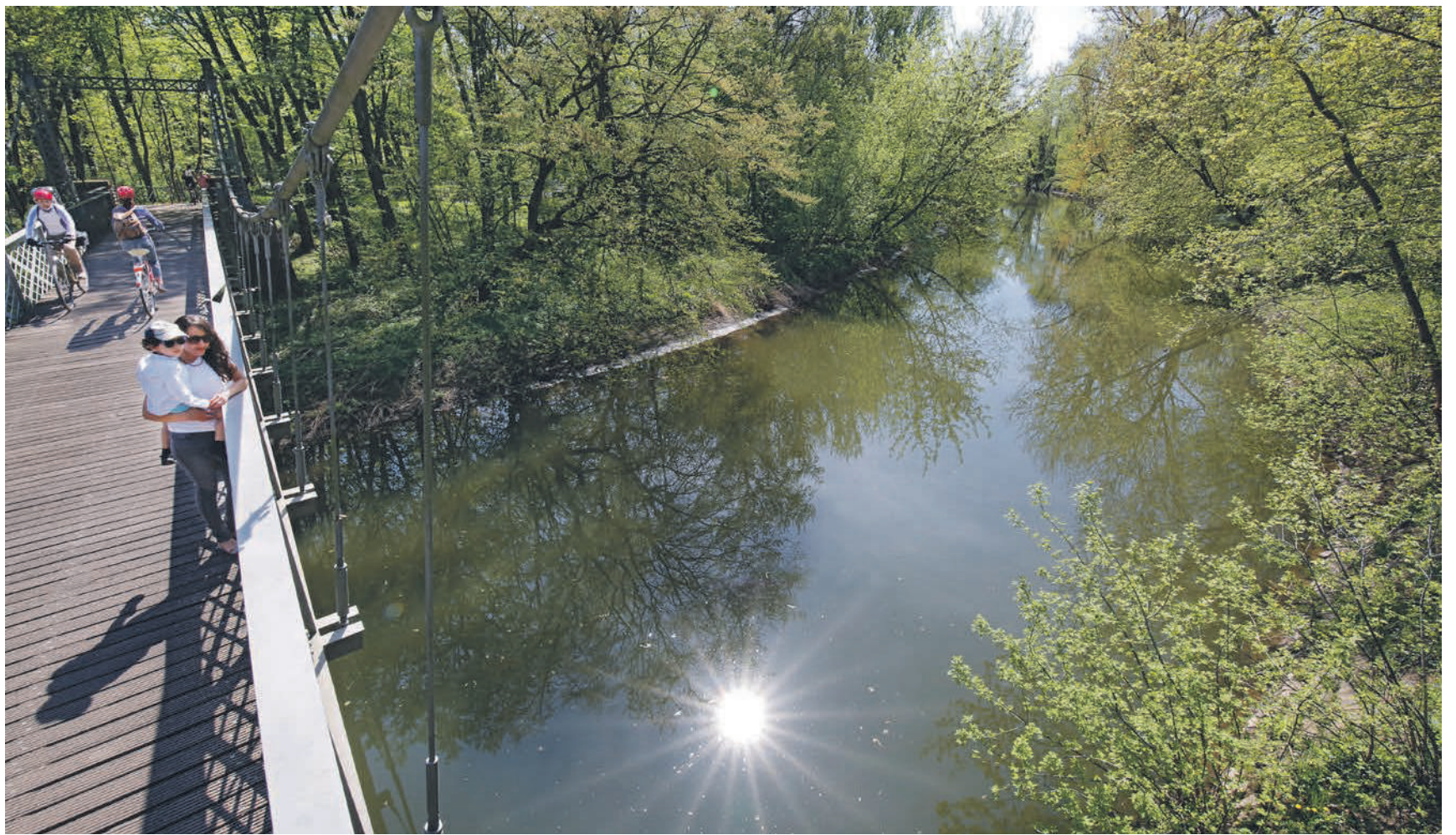
Die Schwanenbrücke führt über die Wilde Saale und verbindet das Weinbergufer mit dem westlichen Teil der Peißnitz.
