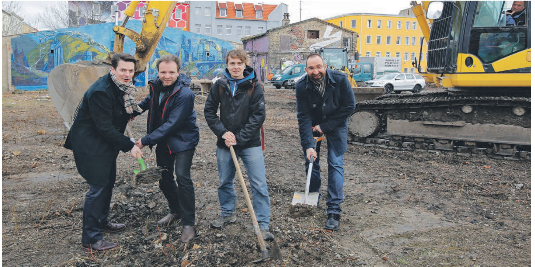
Ein Bürgerpark entsteht derzeit auf der Freifläche an der Landsberger Straße 29 in Halle-Ost. Der erste Spatenstich erfolgte am 13. März 2018 . Vor Ort griffen die Projektbeteiligten zu Hacke und Schaufel (von links): Stefan Anspach, Vorstand der Montag Stiftung Urbane Räume, Kyrill Hirner von der Urbanen Nachbarschaft Freimfelde, Danilo Halle von der Freiraumgalerie sowie Uwe Stäglin, Beigeordneter für Stadtentwicklung und Umwelt. Die Idee geht auf das „Bürgerschaftliche Quartierskonzept Freimfelde“ zurück, das die Bewohnerinnen und Bewohner gemeinsam mit der Urbanen Nachbarschaft entwickelt und Ende September 2017 im Stadtrat vorgestellt haben. Das größte Projekt ist dabei der Bürgerpark. Geplant sind auf dem rund 3000 Quadratmeter großen Areal unter anderem ein Spielplatz und ein Apotheker-Garten. Foto: Thomas Ziegler
