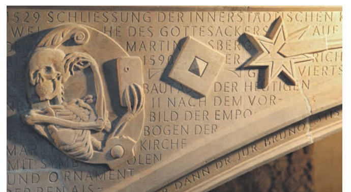
Tod mit Handy: Moderne Motive wurden in Abstimmung mit dem Denkmalschutz verwendet, wenn der originale Schmuck des Grabbogens zerstört war.
