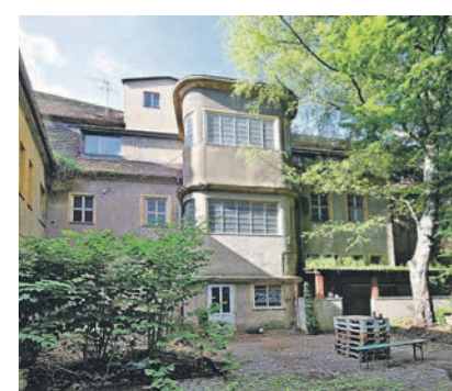
Im Hof der ehemaligen Poliklinik inmitten der Altstadt gibt es auch einen Anbau aus den 1920er Jahren. Foto: Thomas Ziegler
