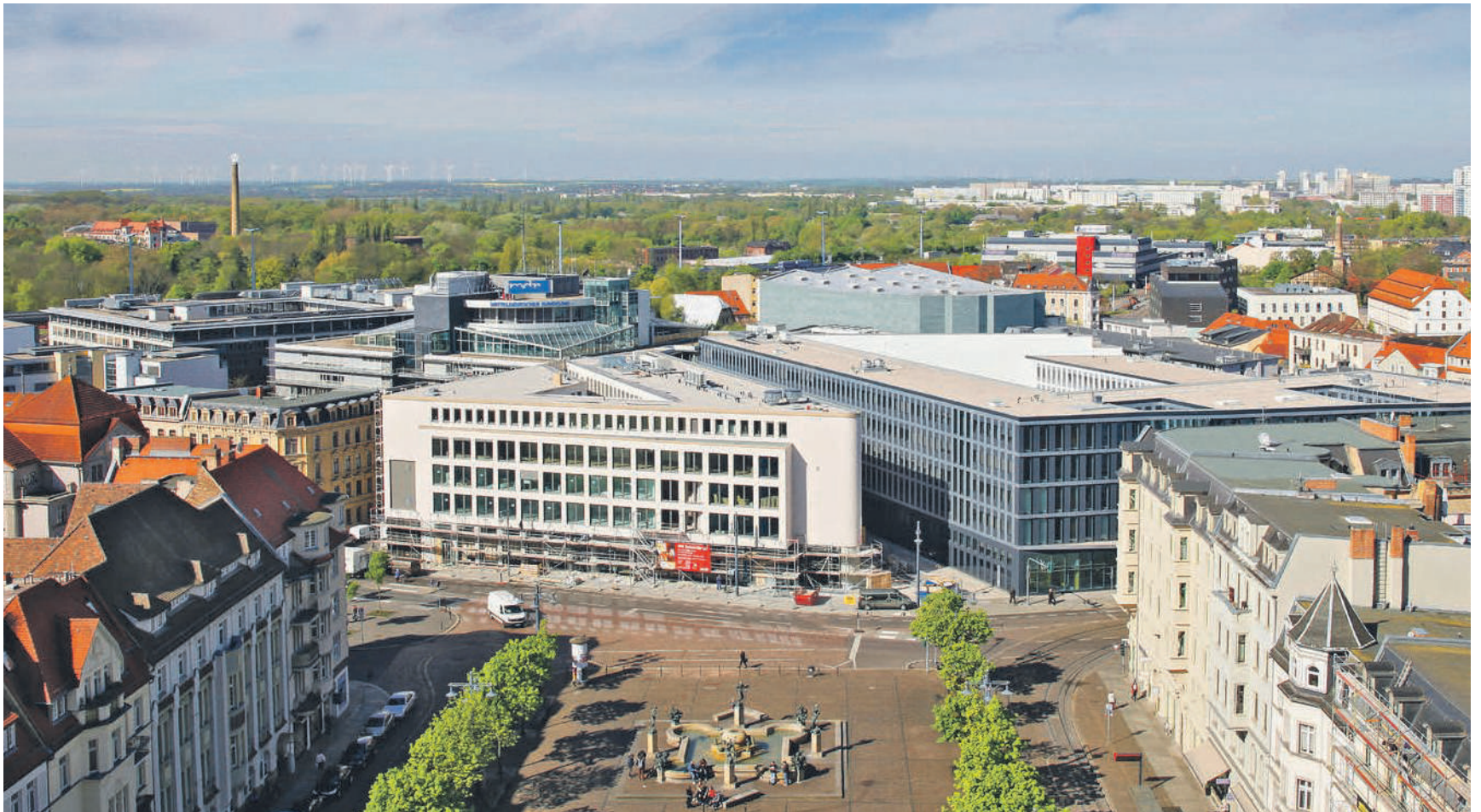
Neben dem neuen Finanzamt Halle (Gebäude hinten rechts im Foto) ist nun auch das Hotel- und Geschäftshaus am Hallmarkt fast fertig – und schließt damit eine jahrelange Baulücke. Fotos: Thomas Ziegler
