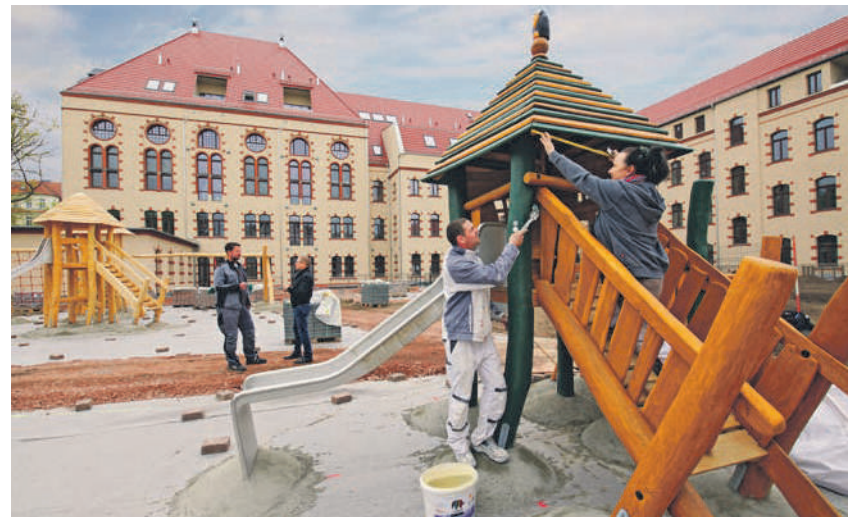
Letzte Handgriffe an den Außenanlagen des Wohnparks im Paulusviertel
