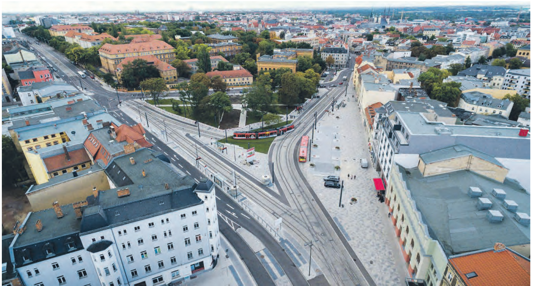
Vorfahrt für die Straßenbahn: Die Neugestaltung des verkehrsreichen Steintors ist eines der wichtigsten Teilprojekte des Stadtbahn-Programms in Halle. Für 22 Millionen Euro wurden sämtliche Verkehrsanlagen neu gebaut und die Freiflächen gestaltet. Fotos: Kappa, Felix Abraham, Thomas Ziegler
