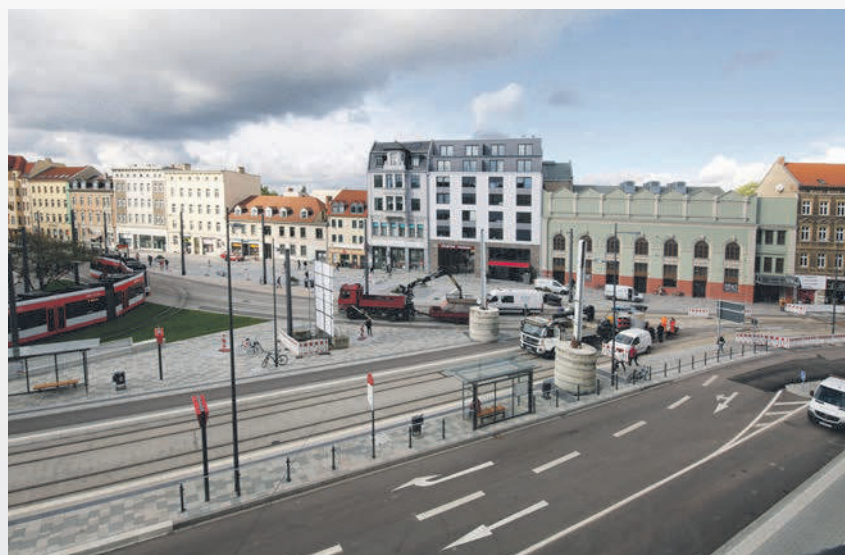
Der Umbau des Steintors ist Bestandteil des Stadtbahnprogramms und wird im Jahr 2017 abgeschlossen sein. Der Platz hat sich zu einem modernen Verkehrsknoten entwickelt. Fotos: Thomas Ziegler
