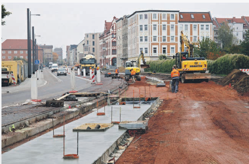
Der Böllberger Weg wird in zwei Abschnitten umgebaut. Bis zum Jahr 2017 werden die Arbeiten im nördlichen Teil beendet sein. Ein Jahr später soll auch der südliche Abschnitt fertig sein.
