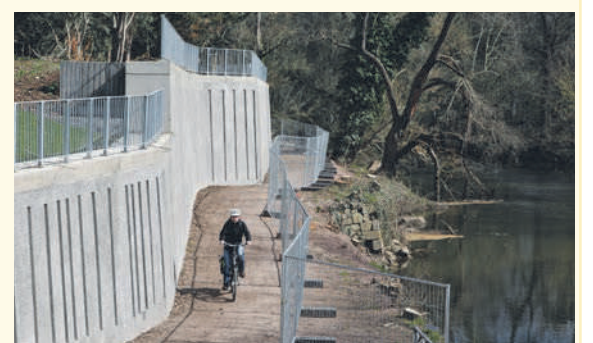
Der Saaleradweg gegenüber der Nordspitze der Peißnitz zwischen Talstraße und Schwänenbrücke befindet sich am Fuß der im vergangenen Jahr fertiggestellten Stützmauer. Er wird in diesem Jahr asphaltiert.
