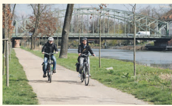
Auf dem Saaleradweg führt die Stadt Halle im Rahmen der Fluthilfe des Landes gleich mehrere Maßnahmen zur Schadensbeseitigung durch. So wird unter anderem der Weg zwischen Holzplatz und der Hafenbahnbrücke asphaltiert.
