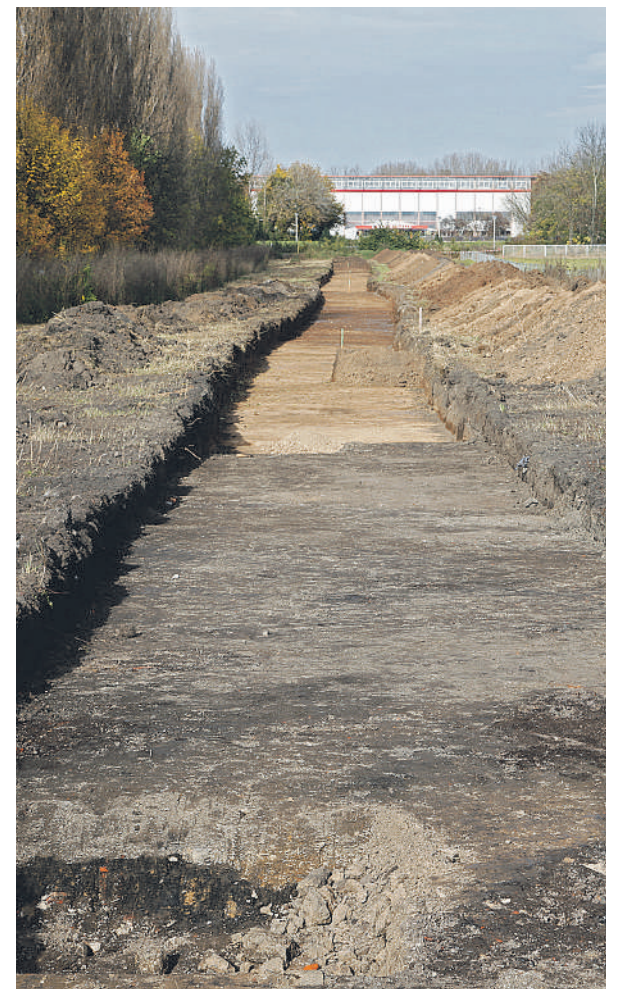
Am neuen Gimritzer Damm haben die Tiefbauarbeiten für die ersten 400 Meter der Anlage begonnen.
