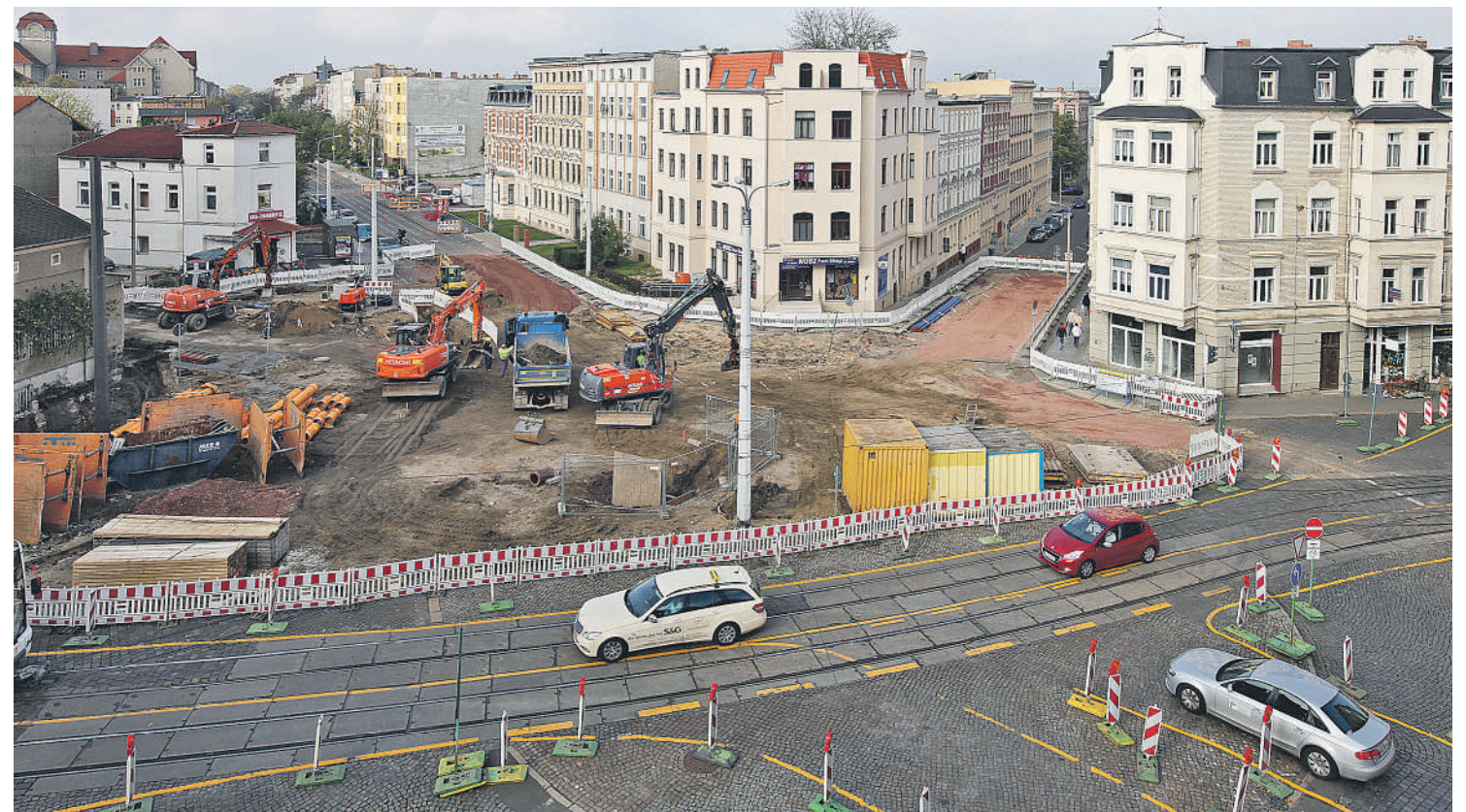
Seit Anfang Oktober 2014 ist der Rannische Platz eine Großbaustelle. Der Verkehrsknoten mit seinen sieben einmündenden Straßen wird im Rahmen des Stadtbahnprogramms bis zum Herbst 2015 neu gestaltet. Neben den Gleisanlagen werden auch alle Ver- und Entsorgungsleitungen erneuert.
