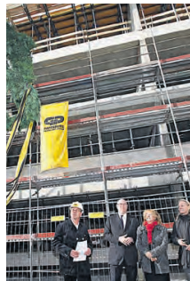
Der Richtkranz schwebt. Ende 2013 soll der erste Bauabschnitt fertig sein.
