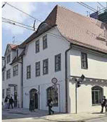
Sanierte Ecke: Waisenhausbuchhandlung und Bistro „Tranquebar“.
