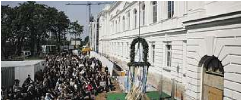
Die Arbeiten am neuen Hauptsitz der Leopoldina, Nationale Akademie der Wissenschaften, gehen zügig voran. Im Mai konnte unter Beisein zahlreicher Vertreter aus Bund und Land Richtfest auf dem Jägerberg gefeiert werden. Das ehemalige Tschernyschewski-Haus wird gegenwärtig für rund 17 Millionen Euro saniert. Die Leopoldina hat rund 1300 Mitglieder, darunter 30 Nobelpreisträger, die unter anderem die Bundesregierung beraten. Foto: Thomas Ziegler
