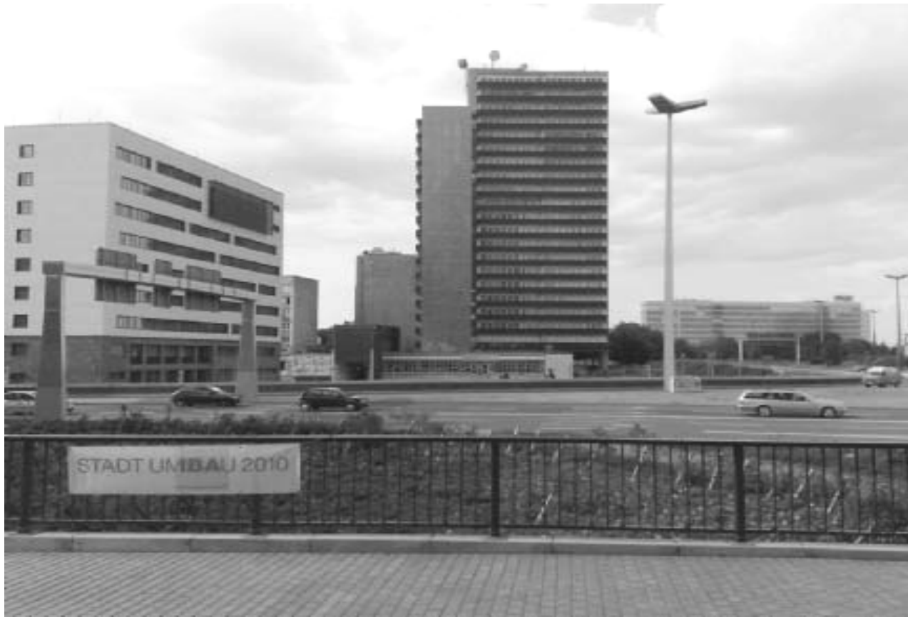
Nördliches Hochhaus am Riebeckplatz: Der Hochhaus-Tisch diskutierte den Erhalt der Stadtbild prägenden Immobilie.
