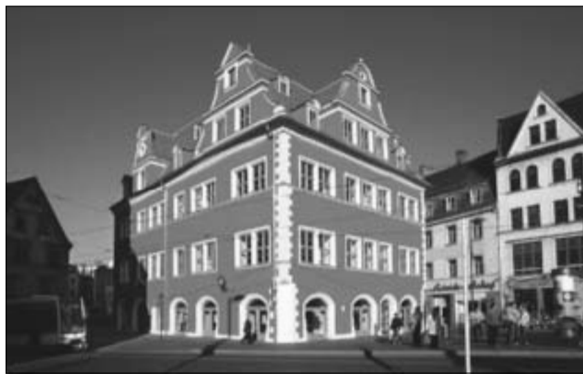
Nach monatelanger Renovierung erstrahlt das historische Gebäude im Herzen von Halle endlich wieder in neuem Glanz. Foto: Th. Ziegler
