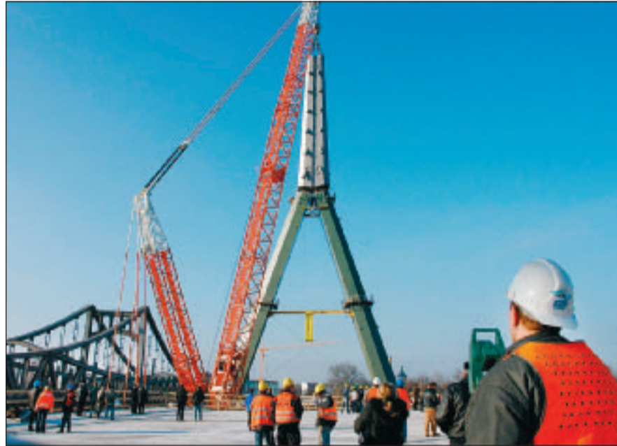
Großbaustelle Berliner Brücke.
