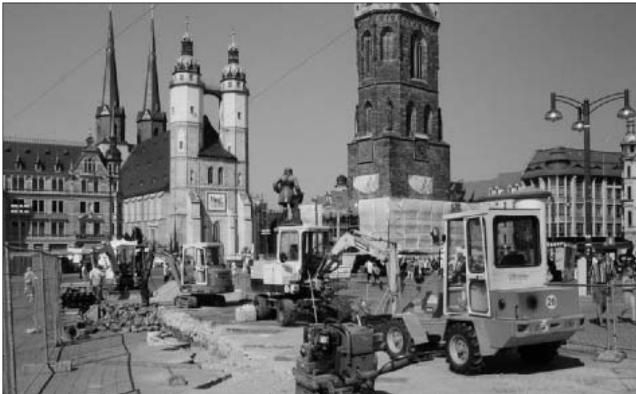
Mit abschließenden Straßenbauarbeiten soll der Umbau des halleschen Marktplatzes Mitte Juni kommenden Jahres beendet sein. Begonnen hatten die umfangreichen Baumaßnahmen im vorigen Monat. Foto: Th. Ziegler
