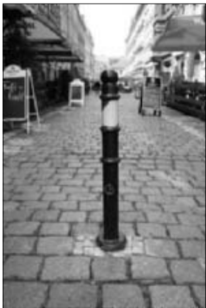
An beiden Einmündungsbereichen zur Kneipenmeile werden Poller installiert. Für den Anlieferverkehr wird je ein Poller in der Zeit von 6 bis 12 Uhr automatisch abgesenkt.
