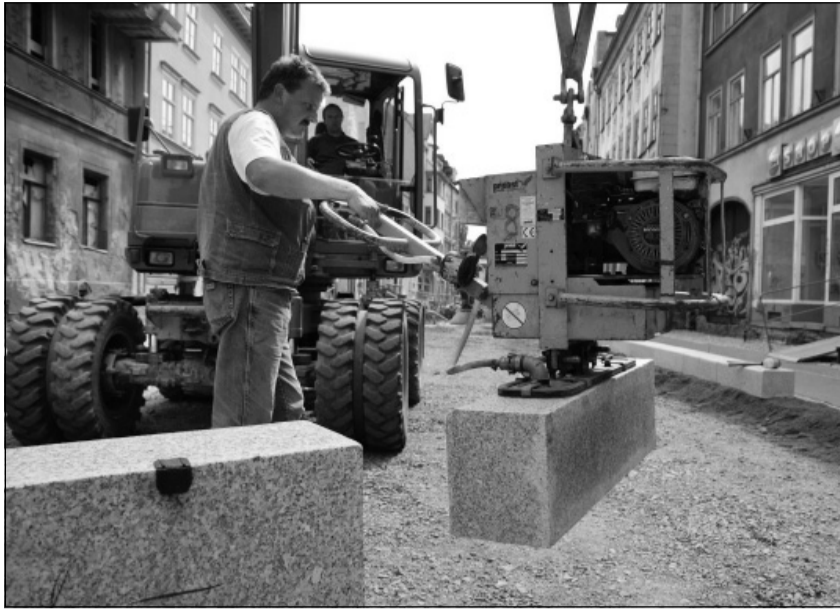
Noch etliche Wochen haben die Bauarbeiter das Sagen. Foto: Th. Ziegler
