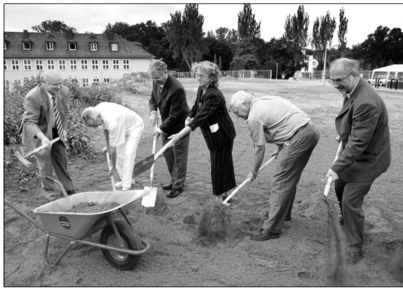
Am Mittwoch, 18. Juli 2003, erfolgte im Beisein von Bürgermeisterin Dagmar Szabados der erste Spatenstich für den zweiten Bauabschnitt am Krankenhaus „Martha Maria“ in Dölau.
