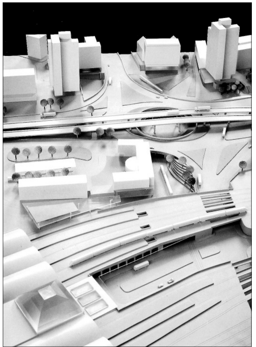
Der neue Riebeckplatz im Modell: im Vordergrund links das Bahnhofsgebäude, darüber die Gleisanlagen mit zum Teil nach oben offener Unterführung (am rechten Bildrand). In der Bildmitte oben beginnt die Franckestraße, rechts daneben die Leipziger Straße. Foto: Th. Ziegler
