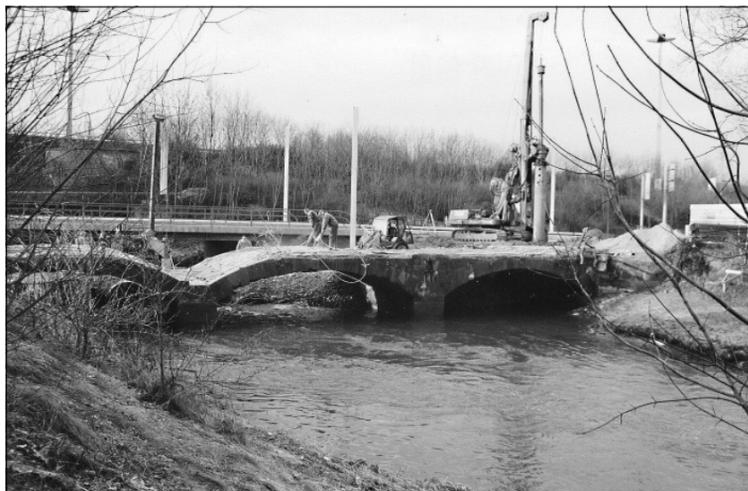
Der vorhandene Fahrbahnaufbau der Schwarzen Brücke musste bis auf die Sandsteingewölbe hinunter angebrochen werden. Foto: FB Tiefbau/Straßenverkehr
