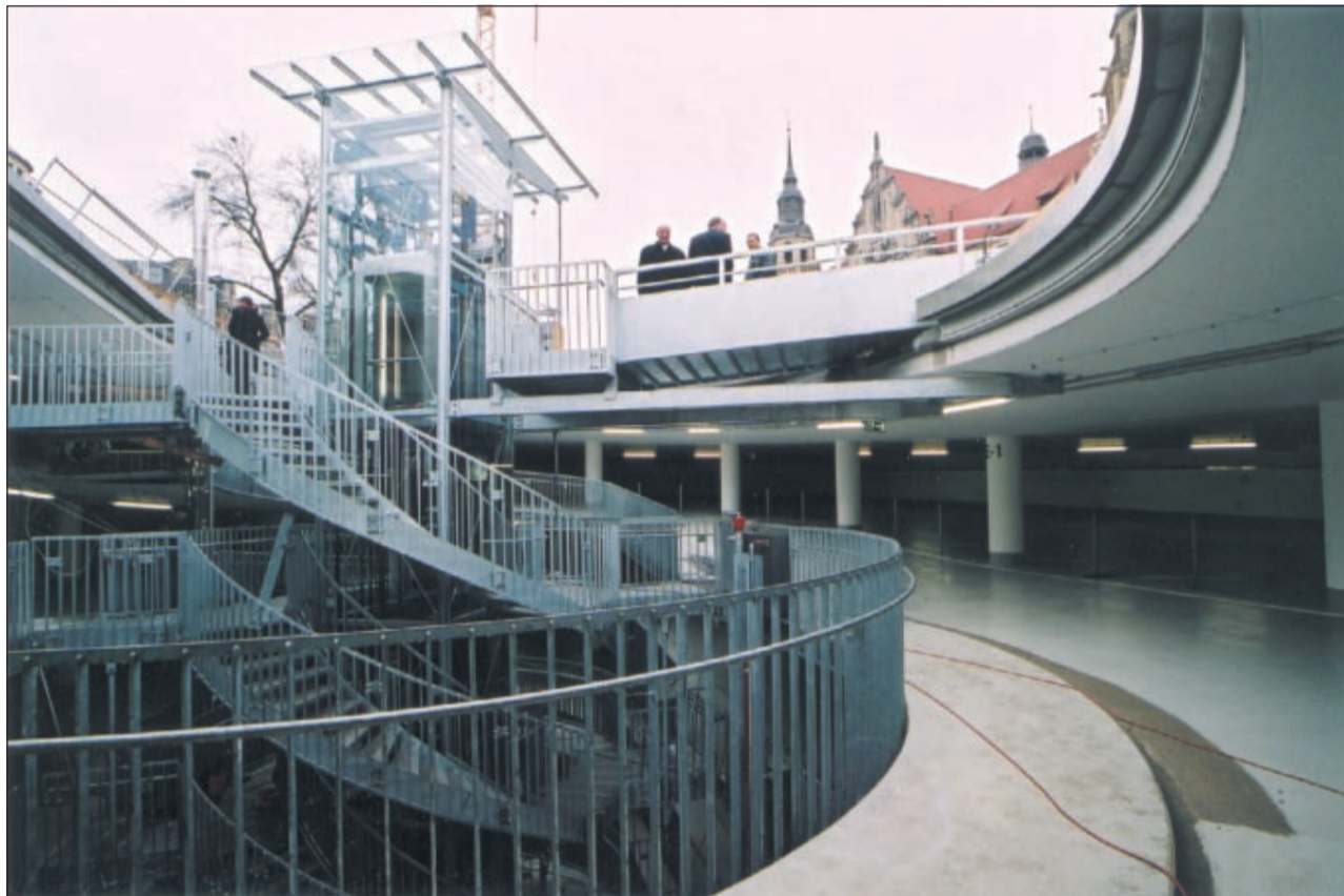
Die neue Tiefgarage am Hansering bietet 400 Parkplätze, darunter 100 Dauerparkplätze.
