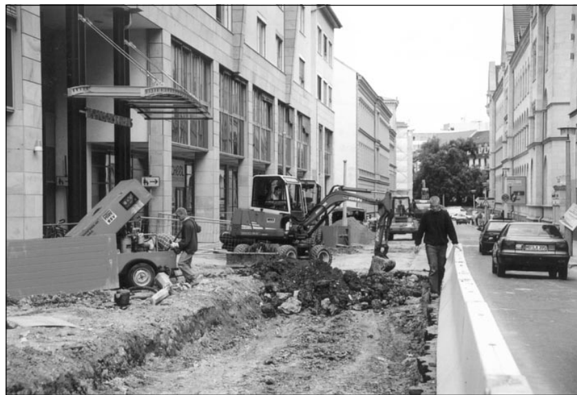
Am Hansering hat in einem ersten Bauabschnitt die Neugestaltung begonnen.
